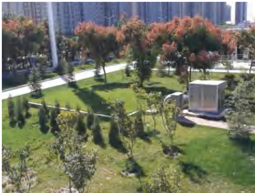
图 7.2-15b 生物土壤滤池工程实景图
