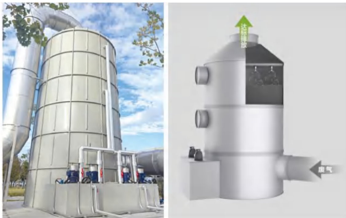
图 7.2-10 水清洗和药液清洗法设备图
